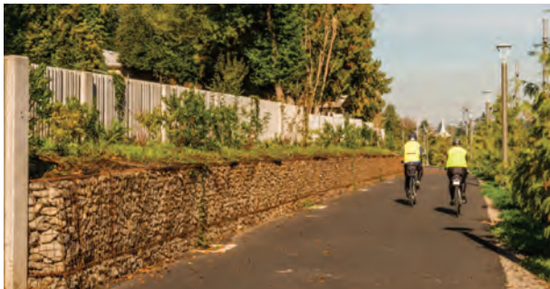
MURO GABION FUENTE DE LA IMAGEN: MAYER/REED
