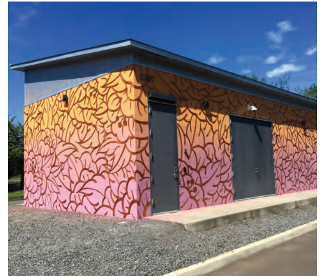
EDIFICIO DE SISTEMAS CON MURAL FUENTE DE LA IMAGEN: KENJI HAMAI STOLL
