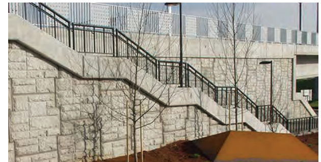
TAPA DE PARED DE HORMIGÓN Y BARANDILLA PINTADA FUENTE DE LA IMAGEN: TRIMET FLICKR
